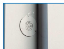
Válvula equilibradora de presión (congelación)
